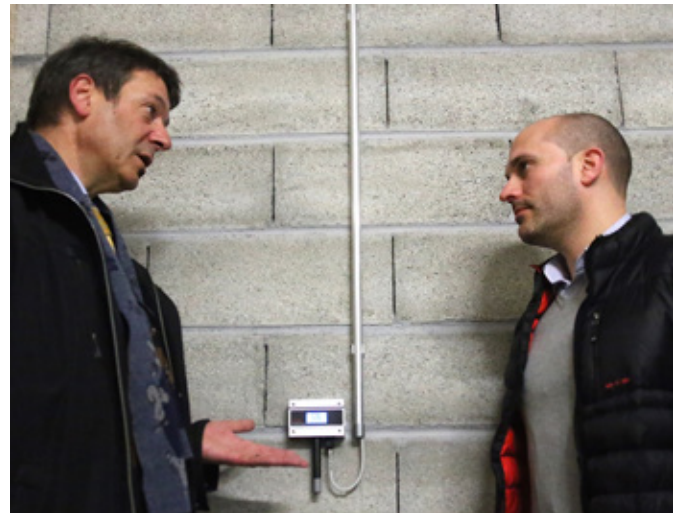
Marc Golay von den Ports France Genève zeigt Marcel Rohrbach von Rotronic, wo einer der Rotronic Messumformer angebracht ist.
