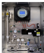
TDL600 Analizzatore di umidità di processo
